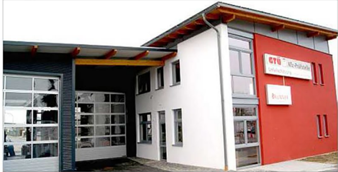
Die Ostansicht der neuen Prüfstelle in der Südeinfahrt 2A.
